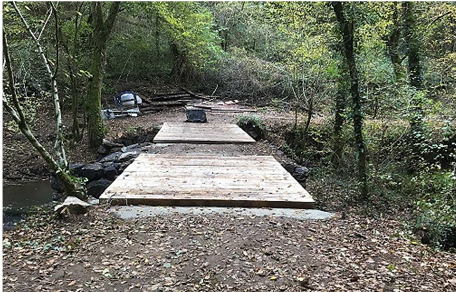
Achèvement de la chaussée ; la courbure originelle du pont est restituée. (cliché du 5 novembre 2018)
