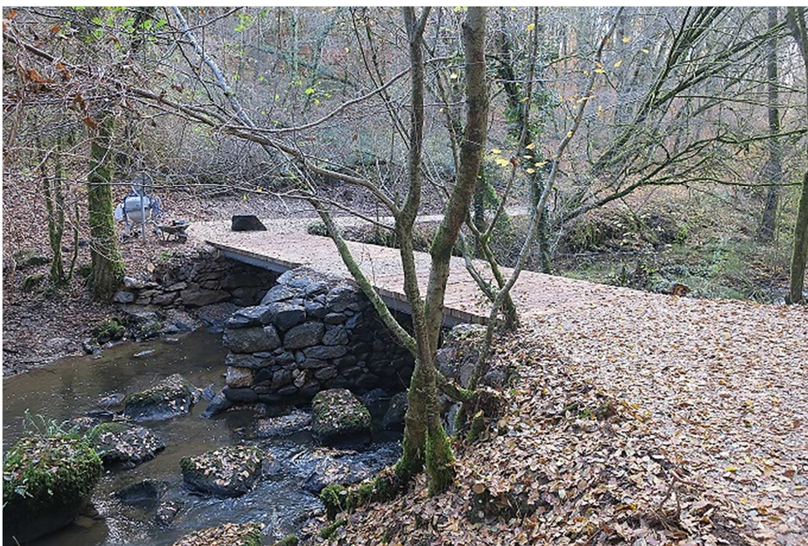
Achèvement du terrassement du chemin (clichés du 17 novembre 2018)
