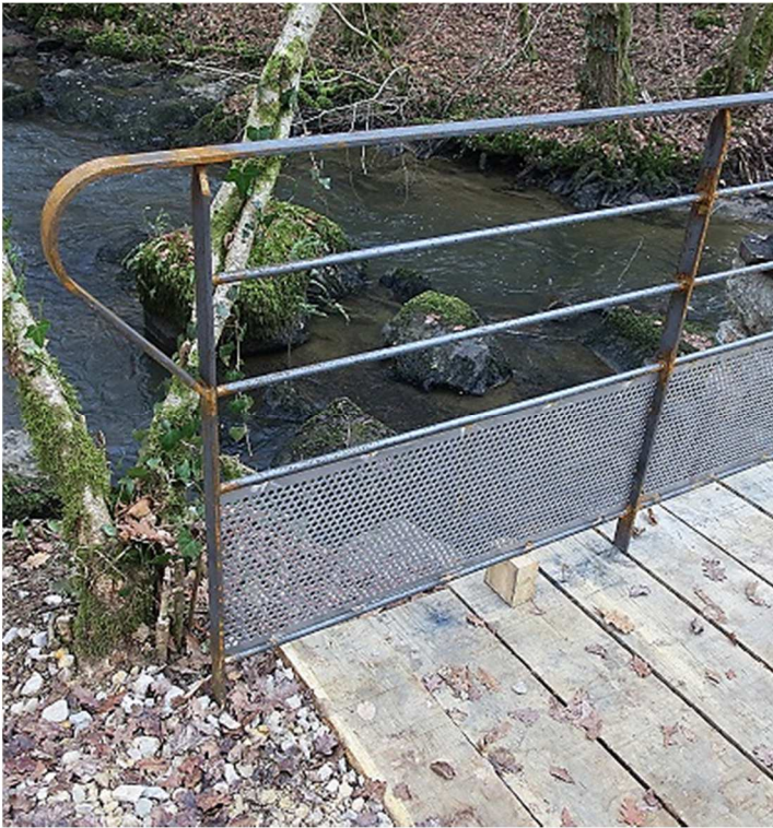
Pose du garde-corps (clichés du 5 janvier 2019)
