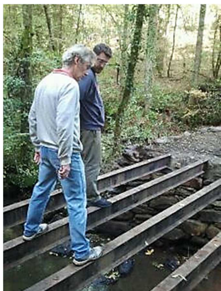
Dépose et enlèvement aux décharges du tablier et de la chaussée (clichés du 10 octobre 2018)
