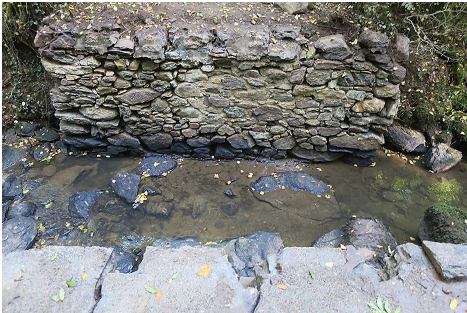
Démoussage et recalage des pierres des culées (clichés du 10 octobre 2018)
