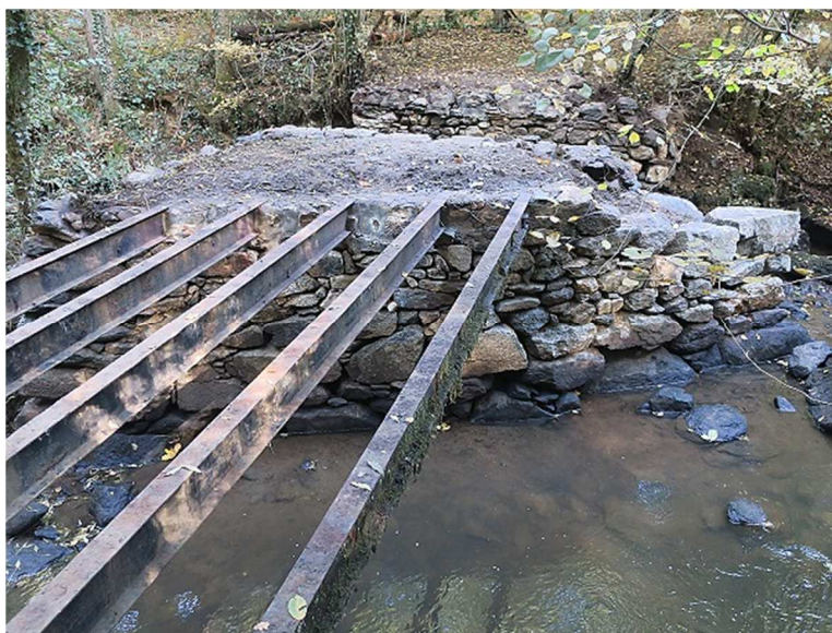
Dépose et enlèvement aux décharges du tablier et de la chaussée (clichés du 10 octobre 2018)
