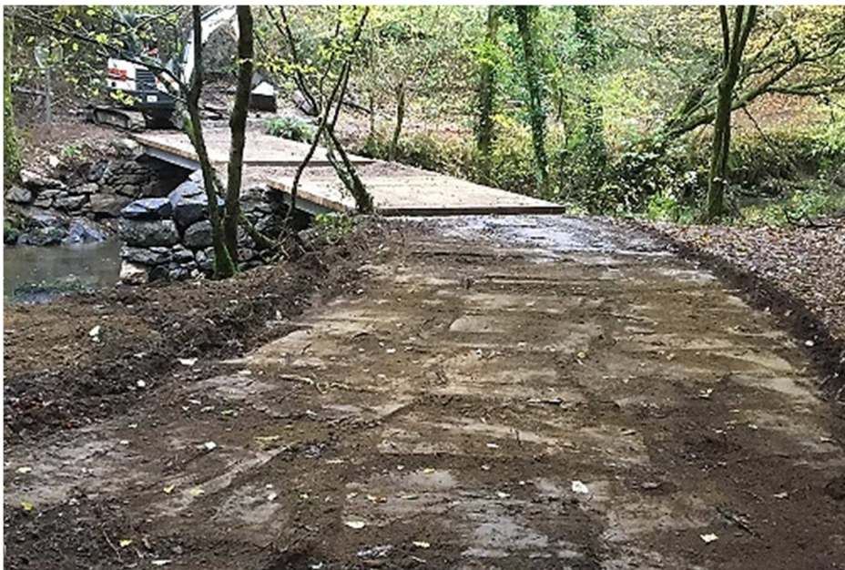
Terrassement du chemin (cliché du 7 novembre 2018)
